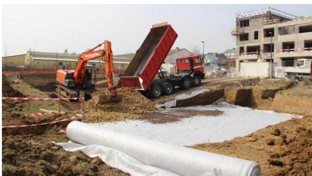
Déblaiement des terres sur toute la surface du terrain. Terrassement en pleine masse jusqu'au niveau inférieur, ainsi que terrassement des rigoles de fondations resp. du radier et de canalisations suivant les indications des plans de l'Architecte et de l'Ingénieur-conseil.
