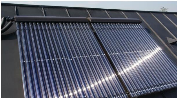
Installation d'un boiler solaire d'une capacité de +/- 400 litres, chauffé par la chaudière à condensation en cas d'insuffisance d'apport d'énergie solaire.
