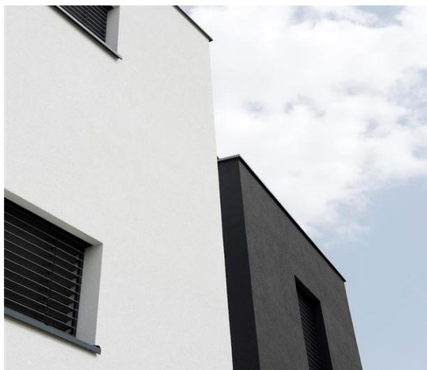
L'isolation est réalisée avec des panneaux d'isolant en laine de roche (type et épaisseur définis suivant le calcul énergétique) recouverts d'un enduit d'armature et un enduit final structure limousin (teintes au choix de l'Architecte et/ou le Promoteur). Le socle pour autant qu'il ne soit pas enterré reçoit un enduit avec une couche de peinture.
